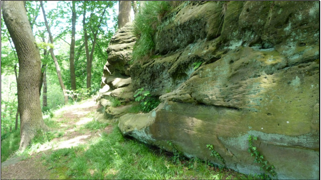
Abbildung 16: Erosion (am Pfad)
